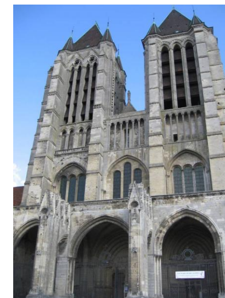
Photographie 3. Cathédrale de Noyon (MH classé) (source : Cabinet Binon)
